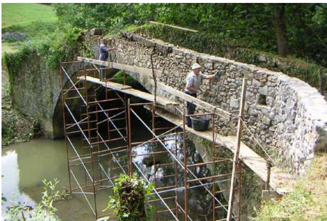
Trabajos de restauración del puente Errotabarri
